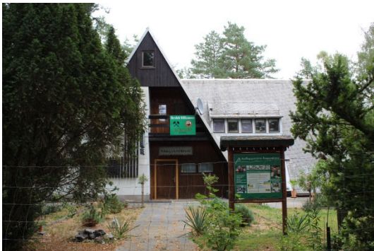
Ehemalige Gaststätte Knappenhütte
