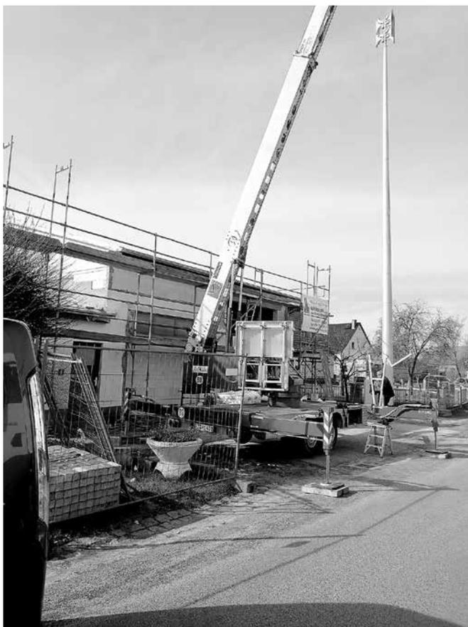
Es wurde auch eine neue Sirenenanlage für die Ortsfeuerwehr Steinitz installiert. Da der vorhandene Schlauchturm keine Funktion mehr hatte und Mängel aufwies, kam es bereits im Herbst 2023 zum Rückbau. Jedoch befand sich auf dem Dach des Schlauchturmes die Sirenenanlage, so dass nun ein neuer Sirenenmast gesetzt und eine Sirenenanlage, entsprechend den geltenden Vorschriften, errichtet werden konnte.
